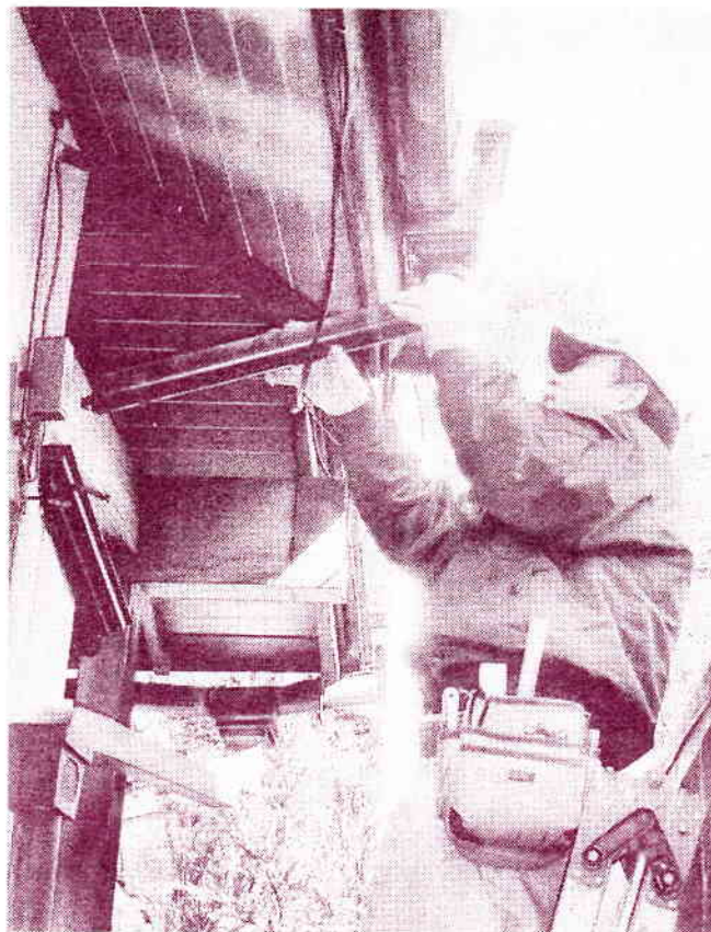
↑施工しているのは軽野板金です。
